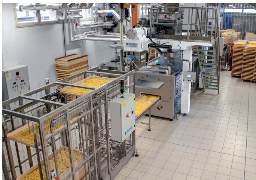
Ligne de production de pâtes alimentaires équipé de SOGEVAC FP. Avec l'aimable accord de la société ITALPAST S.r.l., Parme, Italie
